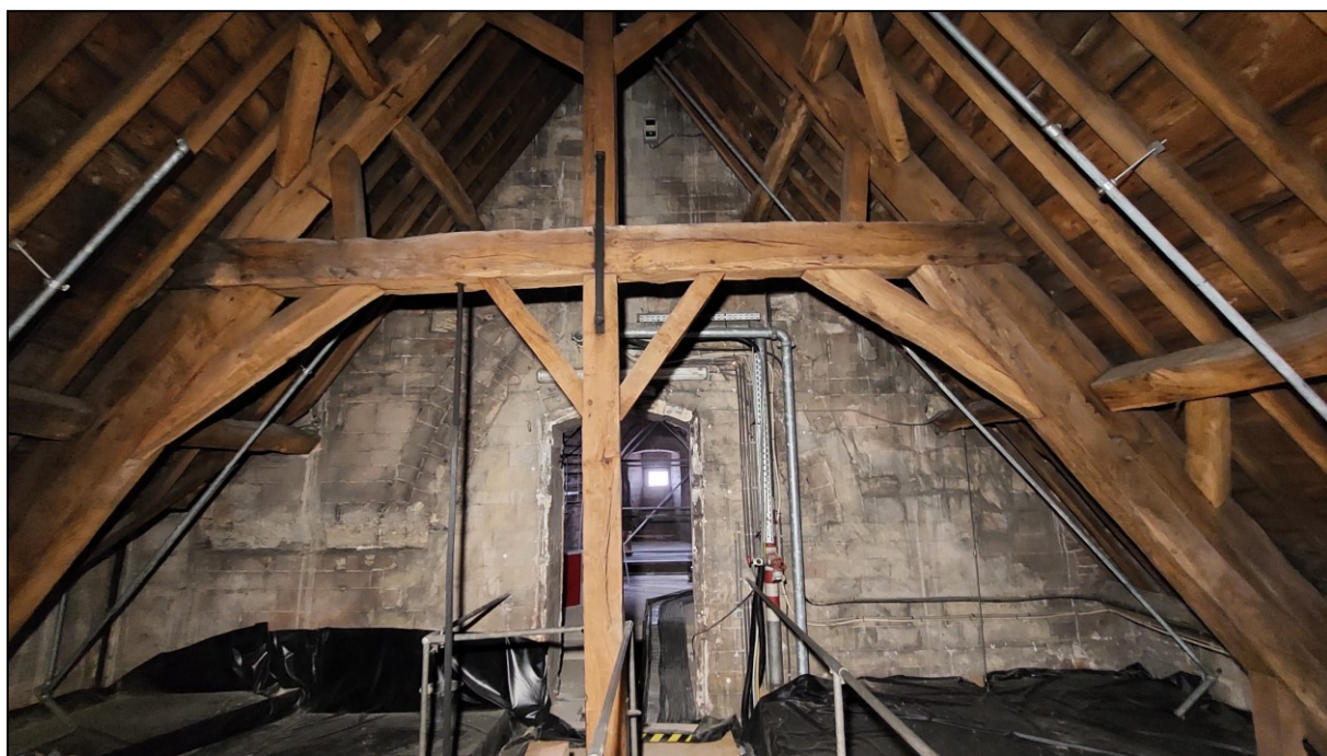
Afb. 66: Westmuur (muur A) van de hoofdzolder.
